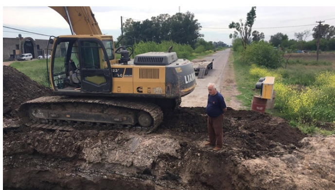
Ilustración 27 – Rotura del Terraplén de Av. Circunvalación
