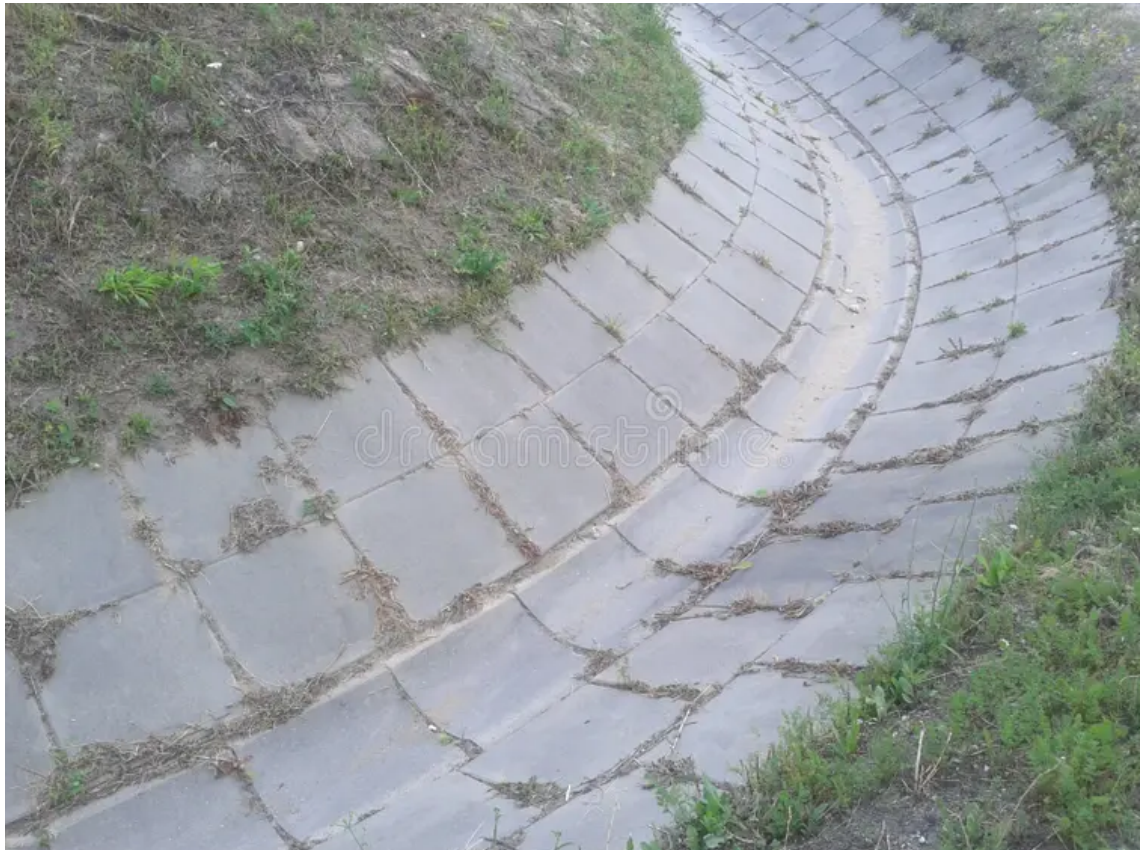
Ilustración - Canal Revestido con paneles de hormigón
