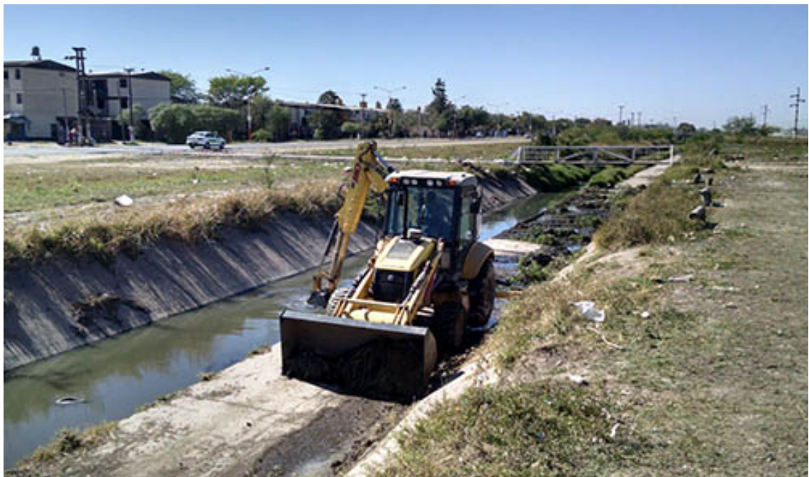
Ilustración – limpieza de canales con maquinaria pesada
